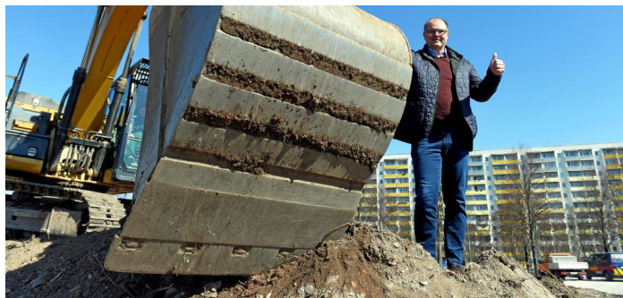
Investor Schallert ließ es sich nicht nehmen, dem Baustart des „Europakarrees“ beizuwohnen. Marco Schmidt
